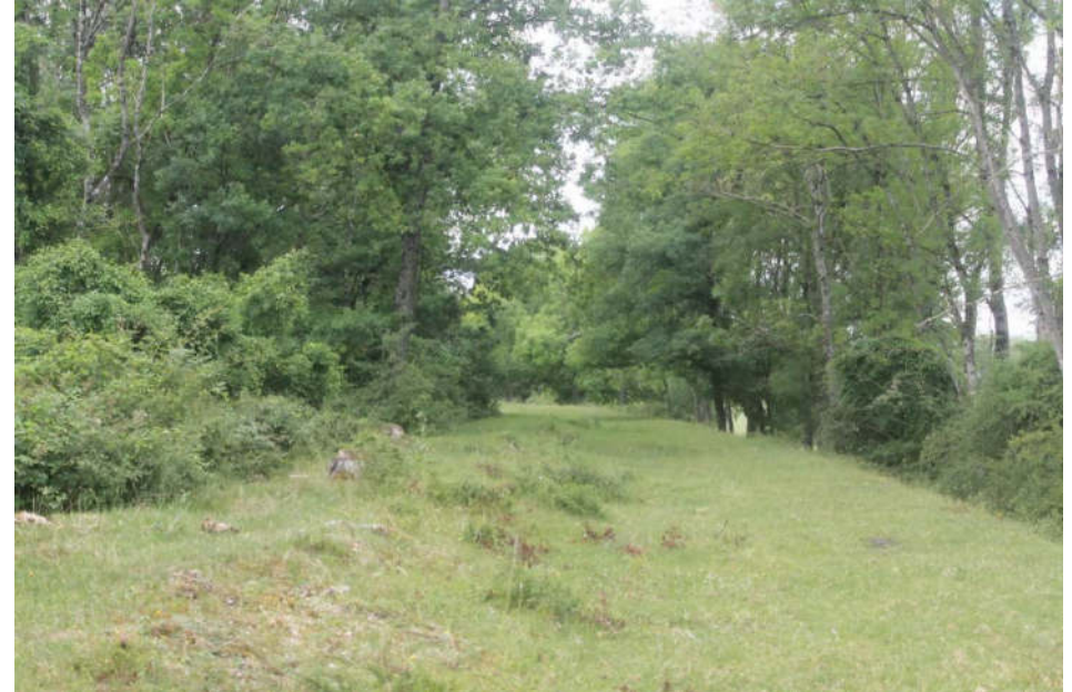
Remblai de la ligne stratégique à double voie vers Dun-sur-Meuse construite en 1934 et démontée en 1942 (2665 et 3049)
