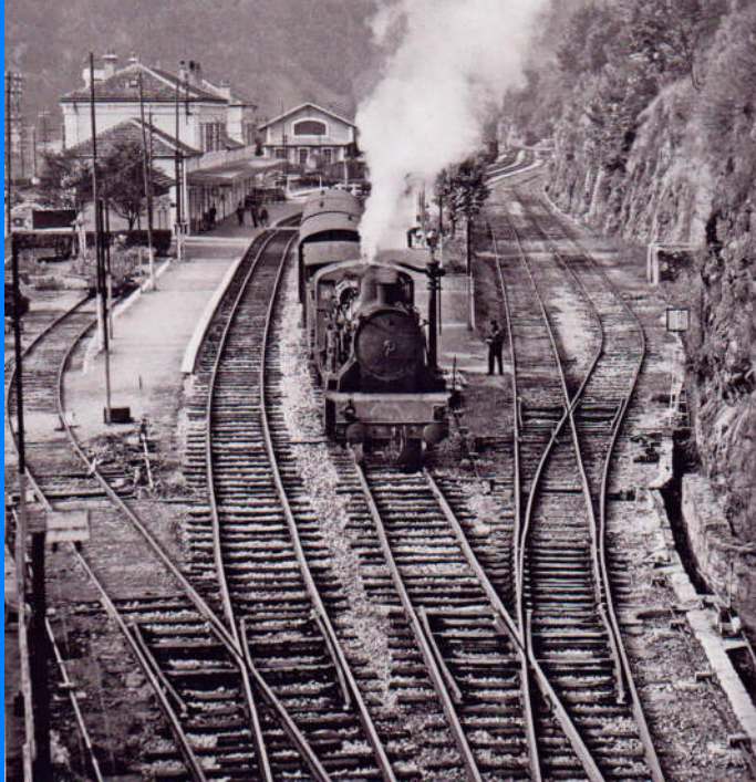
TRÈS BELLE VUE DE SAINT-CLAUDE EN 1964. Un court train comprenant un fourgon et trois voitures, des « trois-pattes » s'appelées à partir en direction de Mores. La longue barre rocheuse de droite résulte des excavations nécessaires pour l'établissement de la gare.
